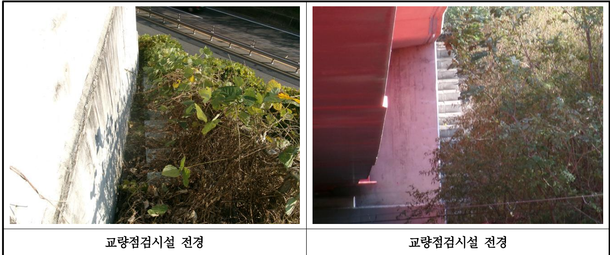
【사진 35.3.47】 교량 점검시설 전경
