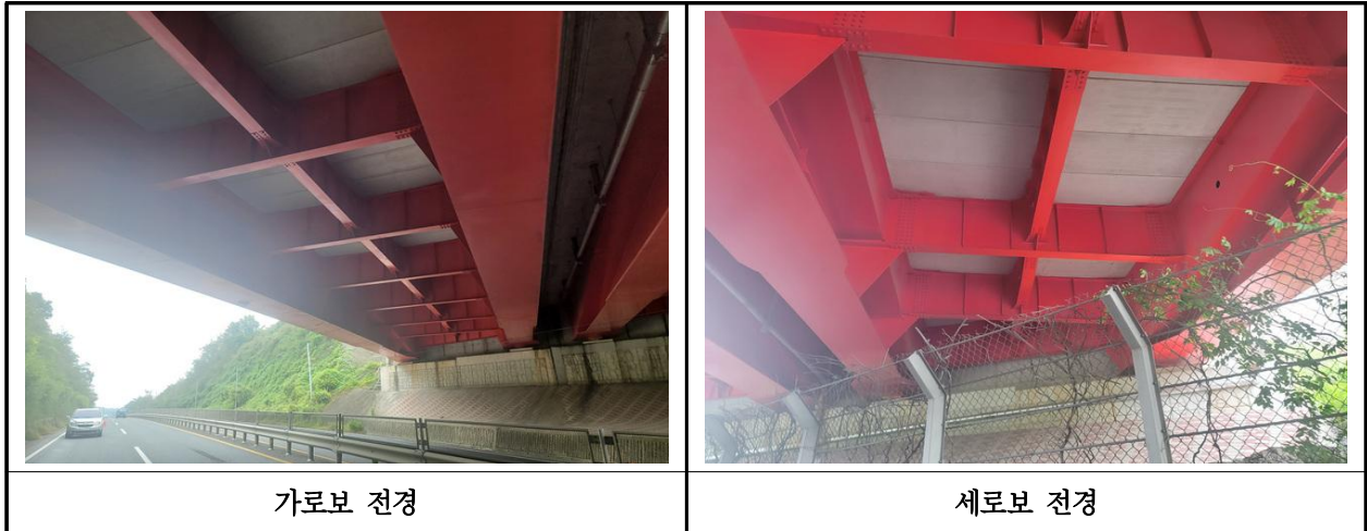
【사진 35.3.6】 가로보 및 세로보 전경
