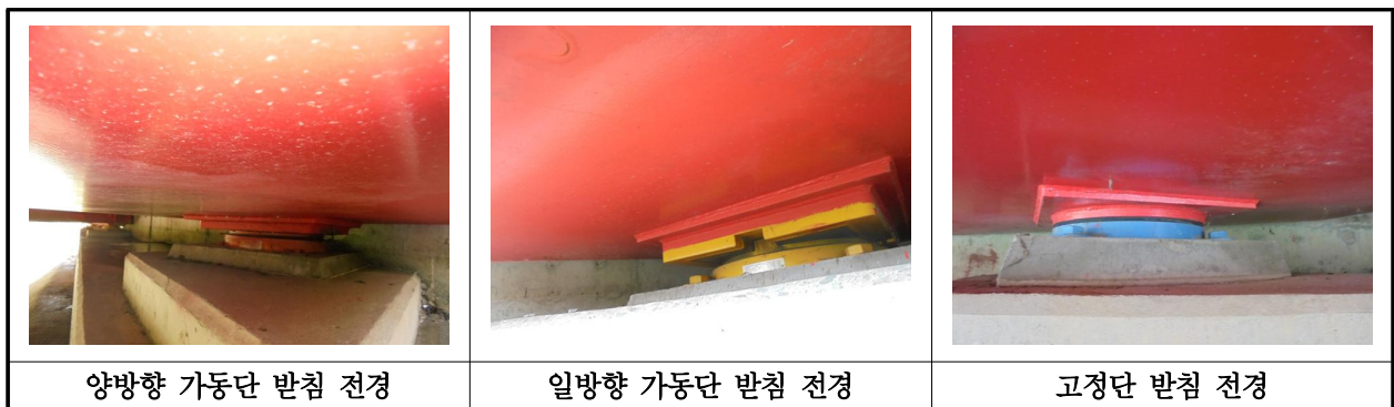
【사진 35.3.33】 교량받침 전경
