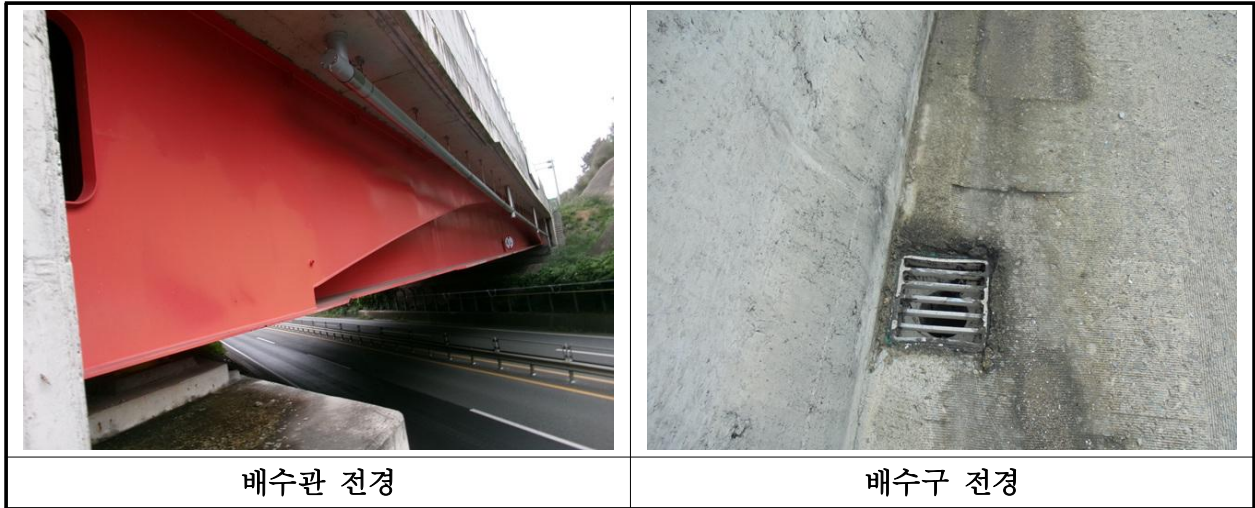
【사진 35.3.19】 배수시설 전경
