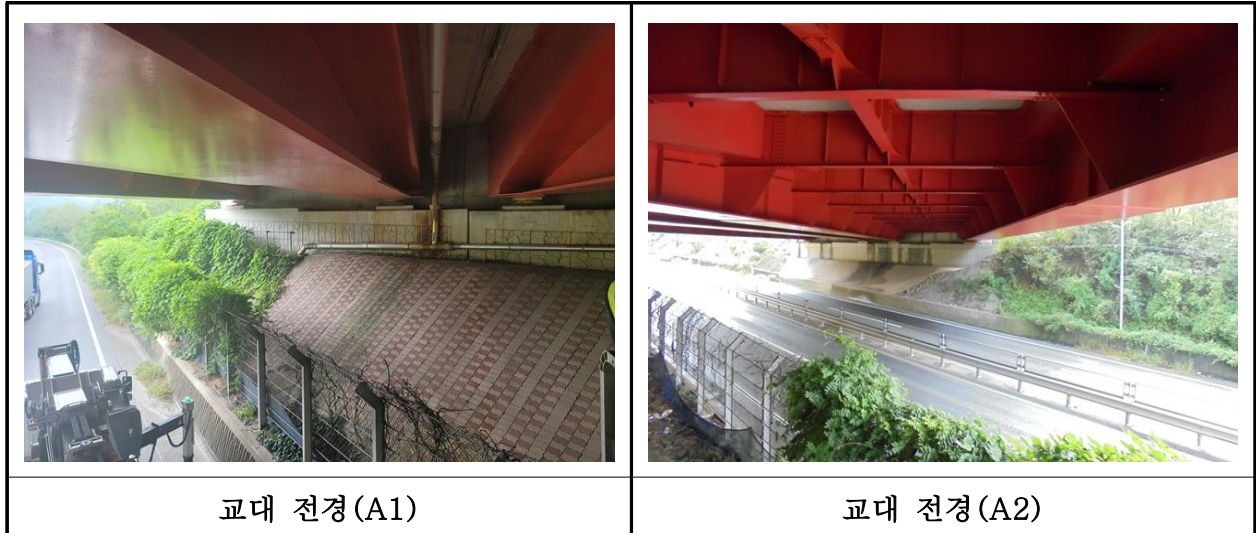
【사진 35.3.31】 교대 전경
