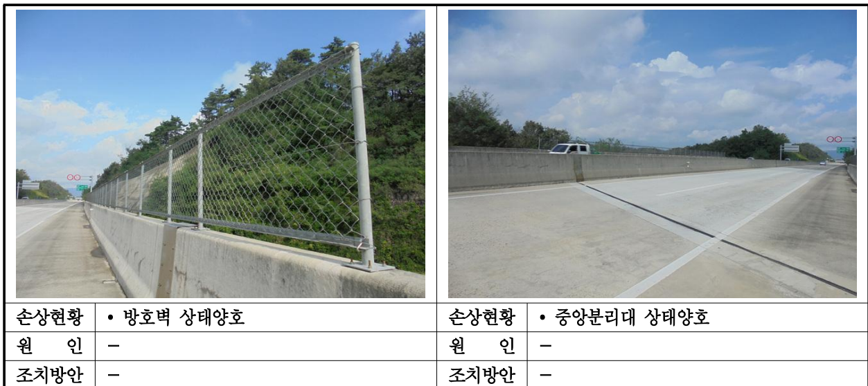
【사진 35.3.22】 방호벽 및 중앙분리대 외관조사 결과
