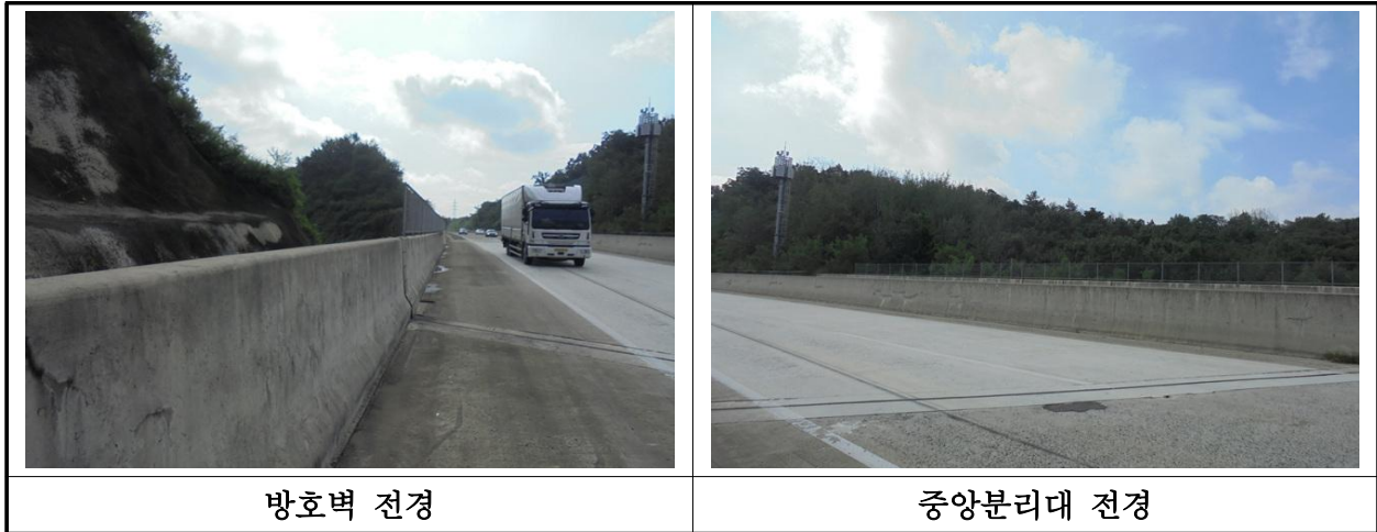
【사진 35.3.21】 방호벽 및 중앙분리대 전경
