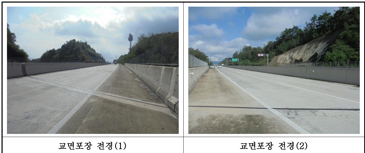
【사진 35.3.40】 교면포장 전경
