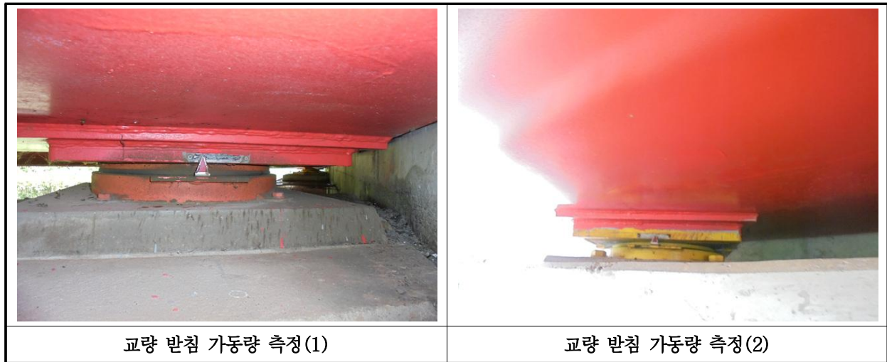
【사진 35.3.36】 교량받침 이동량 측정
