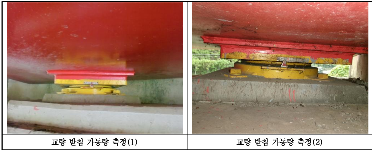
【사진 35.3.13】 교량받침 이동량 측정
