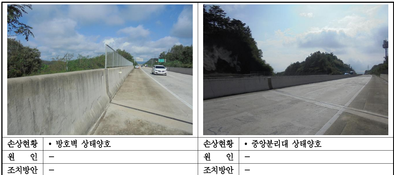
【사진 35.3.45】 방호벽 및 중앙분리대 외관조사 결과
