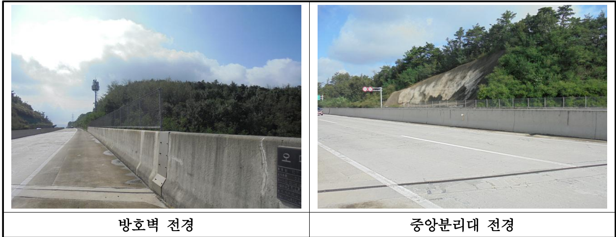
【사진 35.3.44】 방호벽 및 중앙분리대 전경
