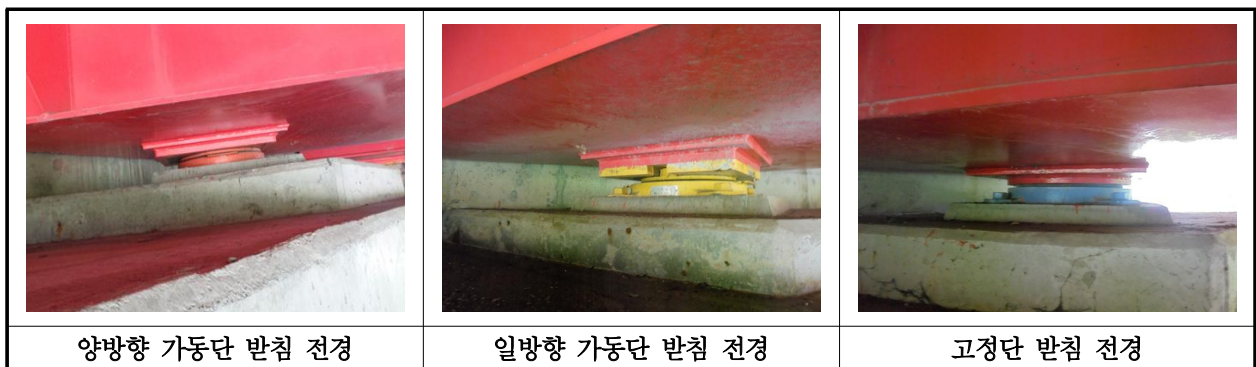
【사진 35.3.10】 교량받침 전경
