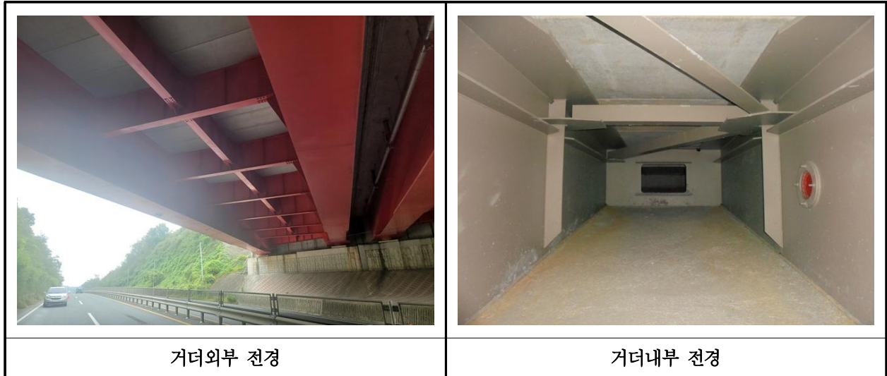
【사진 35.3.4】 거더 전경
