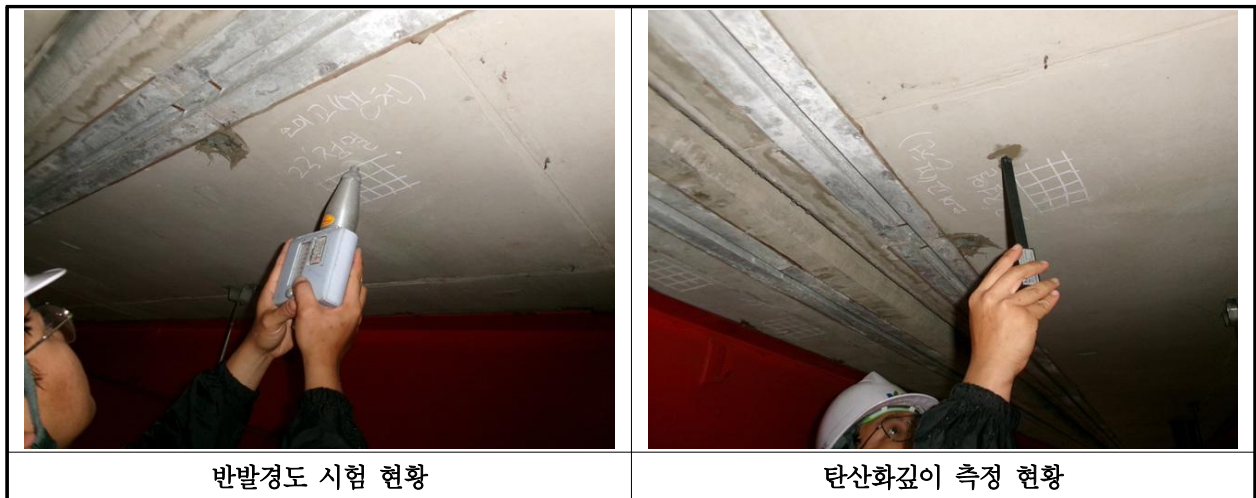
【사진 35.4.1】 콘크리트 내구성조사 현황
