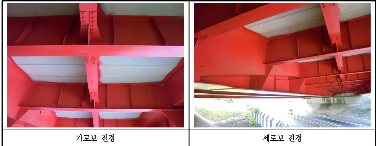
【사진 35.3.29】 가로보 및 세로보 전경
